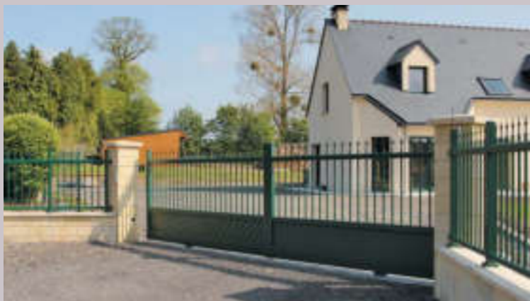
Portail coulissant motorisé avec guidage supérieur, derrière traverse haute.
